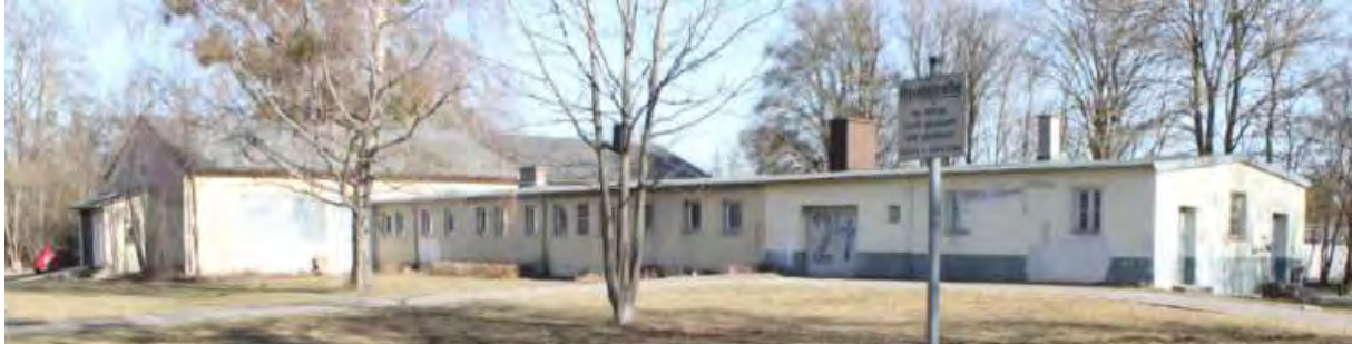
Aktueller Zustand der ehemaligen Sanitärbaracke und des Kantinenbaus
