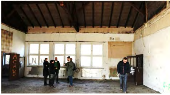
Ehemaliger Gastraum im Kantinenbau
