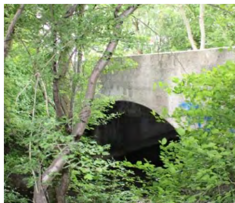
Brücke in der Karlsfelder Straße
