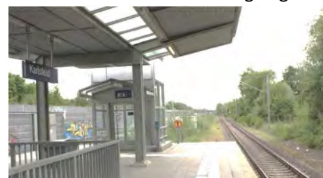
S-Bahnsteig am Bahnhof Karlsfeld
