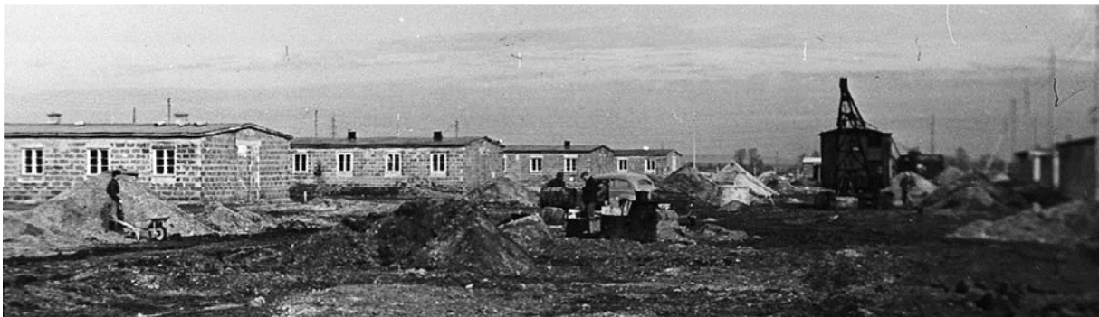
Baumaßnahmen am 14. März 1951. Foto: E. Repnikov
