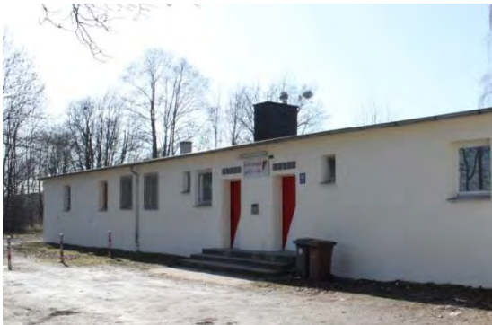
Sanitärbaracke in der Granatstraße 10
