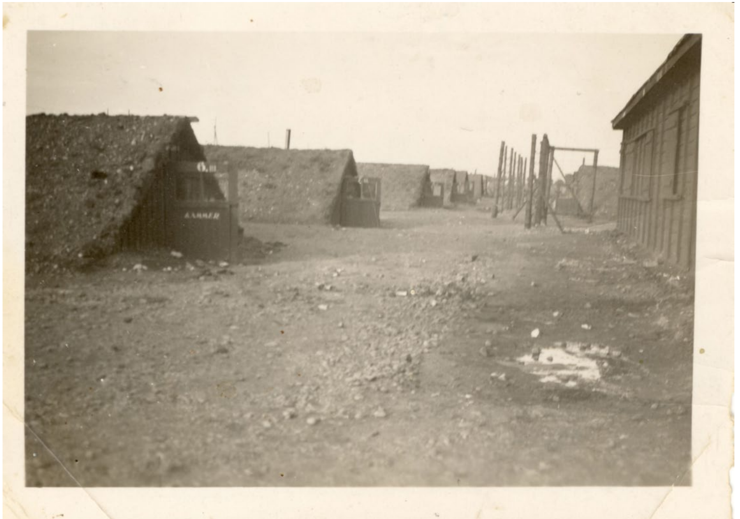
20 – Erdbaracken im Außenlager Türkheim – Quelle: Sammlung Gernot Römer
