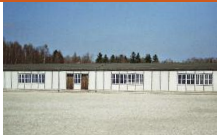
Blick auf eine der beiden rekonstruierten Baracken
